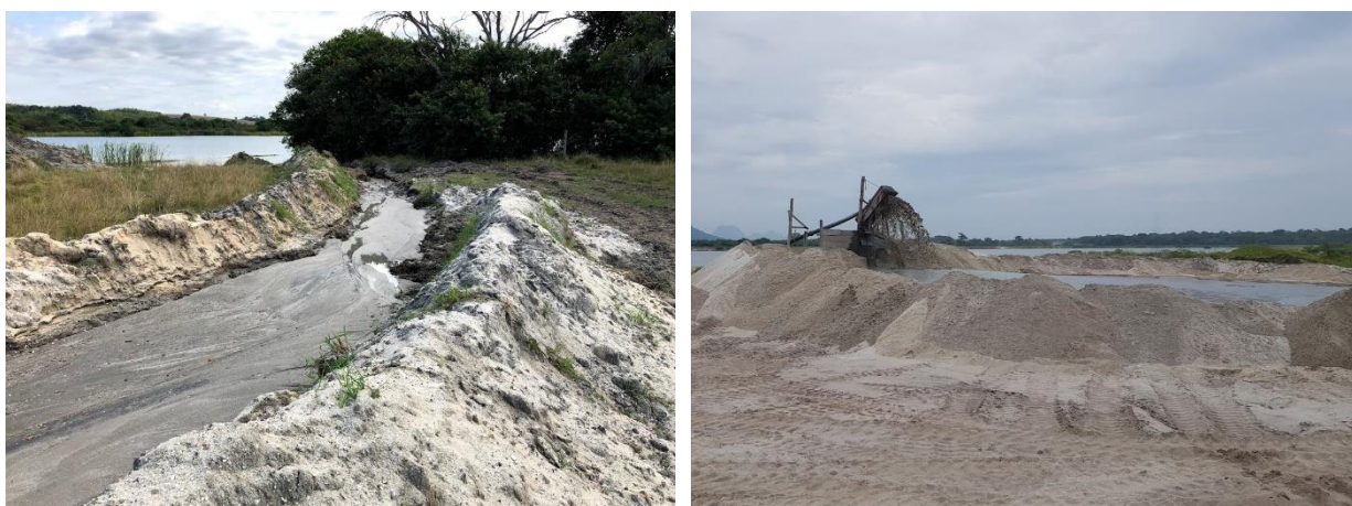
Figuras 12 e 13 – Detalhe da bacia de decantação e canal de drenagem.
