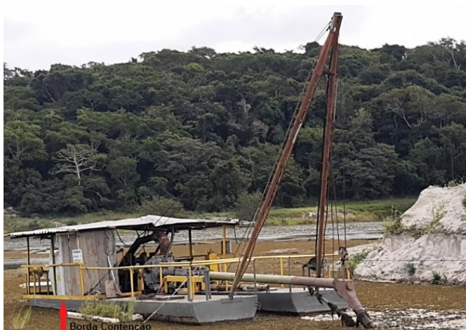
Figura 1 - Balsa de operação em atividade de campo.
